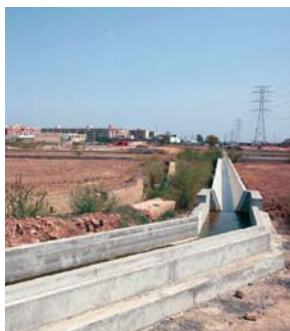
Abb. 134: Kanal in betonierter Ausführung
