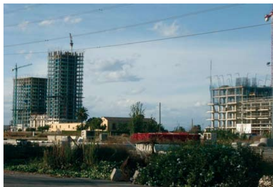
Abb. 125: Alte und neue Bebauung. Sociópolis als visueller Anziehungspunkt.
