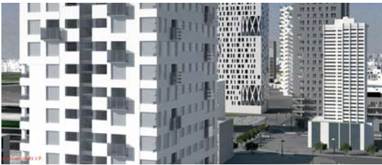
Abb. 144: Wenig ansprechende Gestaltung der gebäudebezogenen Freiflächen
